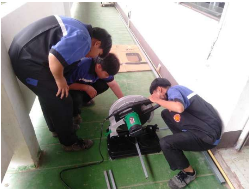
ภาพที่ ข-1 เตรียมอุปกรณ์ขึ้นรูปชิ้นงาน
