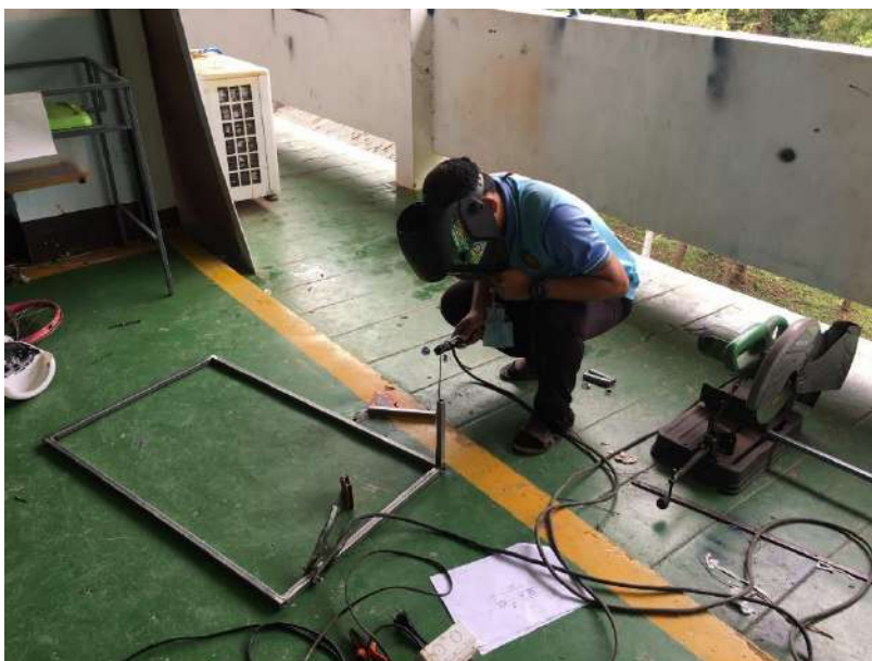
ภาพที่ ข-3 เชื่อมโครงชิ้นงาน
